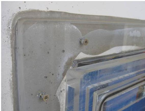
**Bild 3:** Detail Anschluss an WU-Beton
